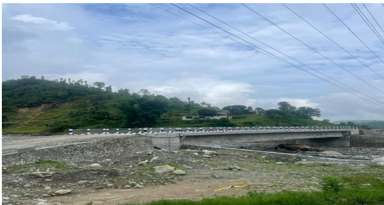
योजनाको नाम:- ठाडीखोला पक्कीपुल घ्याङलेख गा.पा. २,सिन्धुली (Construction of Pre-Stressed RCC Thadi Khola Bridge at Chandanpur Simplephat Road, Ghyanglekh-2, Sindhuli)
